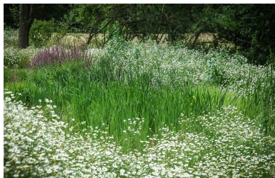
Kořenová čistírna ve Sternberku Zdroj: https://www.korenova-cisticka.cz/
