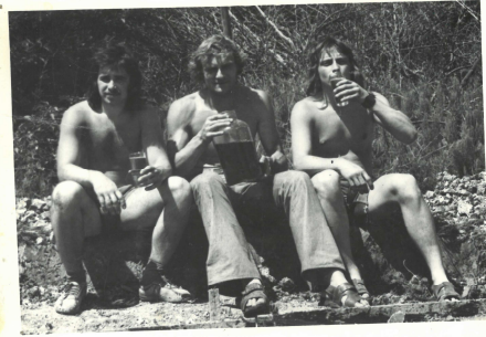
Stavba klubovny, rok 1975. Na fotografii jsou (zleva) František Dejnožka, Miroslav Piša a Václav Krpata. Klubovna stála vedle bývalého hřiště na Podlesí, dnes je z ní ruina na soukromém pozemku. Klubovnu si mládež stavěla svépomočí, materiální podporu poskytovalo tehdejší JZD (Jednotné zemědělské družstvo). A protože na stavbě je žízeň, pro pivo se běhalo „K Horkým“ s velkou sklenicí od okurek.
