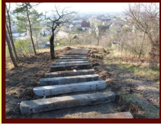
Schodiště je vybudováno ze 100 železničních pražců. V obtížném terénu ho postavili pánové Bohumil Danihelka a Josef Dostálek z Vysoké nad Labem
