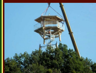
28. září 2013: usazení vrcholové části rozhledny o váze 7 tun
