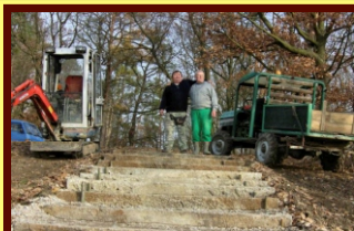
Schodiště je vybudováno ze 100 železničních pražců. V obtížném terénu ho postavili pánové Bohumil Danihelka a Josef Dostálek z Vysoké nad Labem
