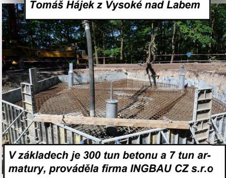
Hloubení 3 metry hluboké jámy pro základy zajistili pánové Oto Hájek a Tomáš Hájek z Vysoké nad Labem
