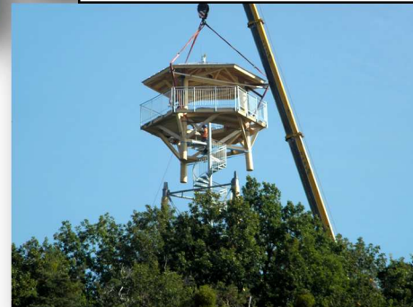
28. září 2013: usazení vrcholové části rozhledny o váze 7 tun
