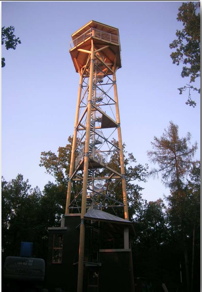
3.10.2013: rozhledna je téměř hotová a připravená ke kolaudaci. Oválný tvar v levé části je zaparkovaná vysokozdvíhací plošina, ze které se ještě budou provádět drobné dokončovací práce.
