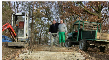
Schodiště je vybudováno ze 100 železničních pražců. V obtížném terénu ho postavili pánové Bohumil Danihelka a Josef Dostálek z Vysoké nad Labem
