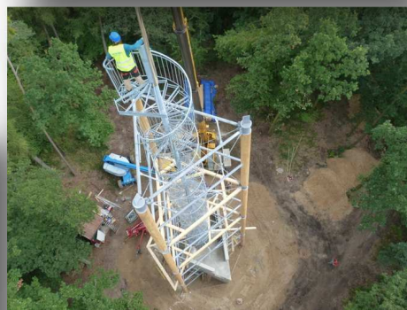
Zdvihání posledního osmimetrového dílu schodiště
